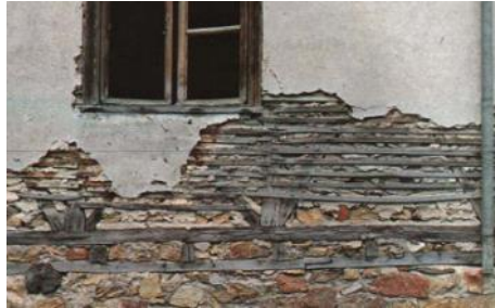
Μπαγδατί Με καρφωτές πήχεις & Υποκείμενη αργολιθοδομή
