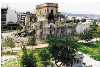
Εικόνα 3 -Ερείπια του Εργοστασίου
